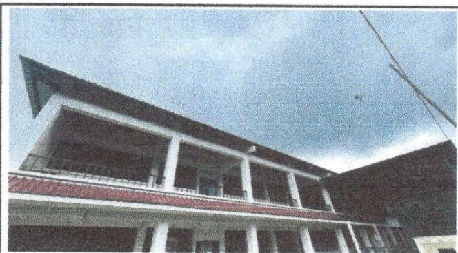
Fotografía 3. Canales y bajadas de agua pluvial
