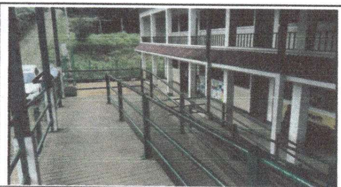
Fotografía 5. Mantenimiento a barandas.
