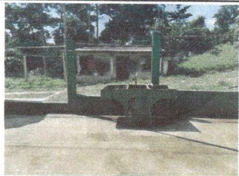
Fotografía 10. Intalación de pila de dos lavaderos.
