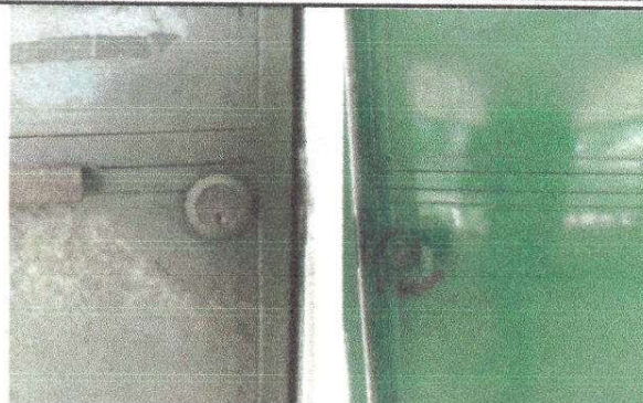
Fotografía 2. Sustitución de chapas de puertas de metal
