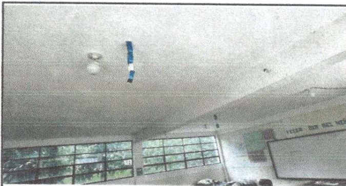
Fotografía 9. Reparación de sistema eléctrico.
