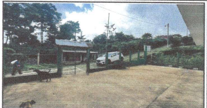
Fotografía 8. Reparación de muro perimetral de block con tubo hg y malla galvanizada, soleras intermedias y columnas.
