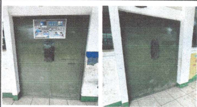
Fotografía 1. Mantenimiento a estructura de puertas de metal.
