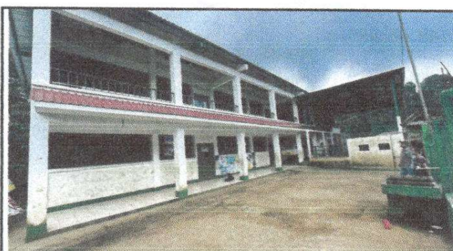
Fotografía 4. Pintura en muros interiores y exteriores.
